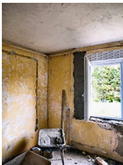
Ugradnja prozora, žbukanje
